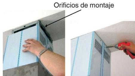
H) Desmontaje de la protección de entrada
